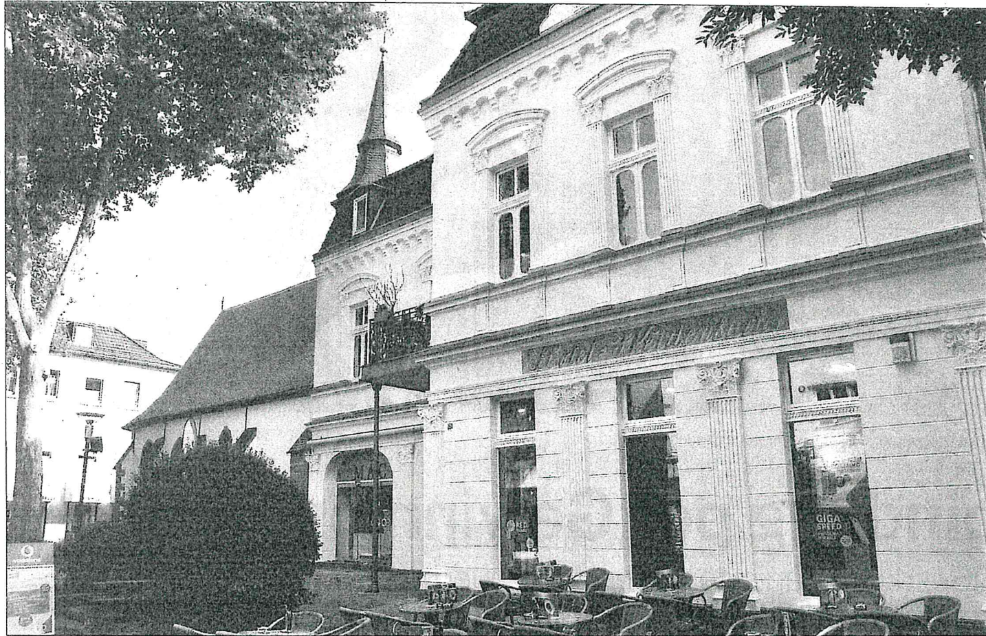
Der Schriftzug aus den 1880er-Jahren wurde bei der Restaurierung der „Alten Post“ wieder freigelegt. (Foto: Fratz)
