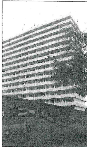
Das Hochhaus soll abgebrochen werden. (Foto: VlamincK)
