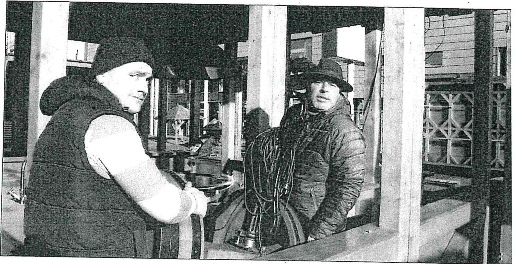
Noch befindet sich das Winterdorf im Bau, ab dem 1. Dezember soll vor dem Medio eine 17 Meter hohe Holzpyramide stehen. (Foto: Vlaminc)
