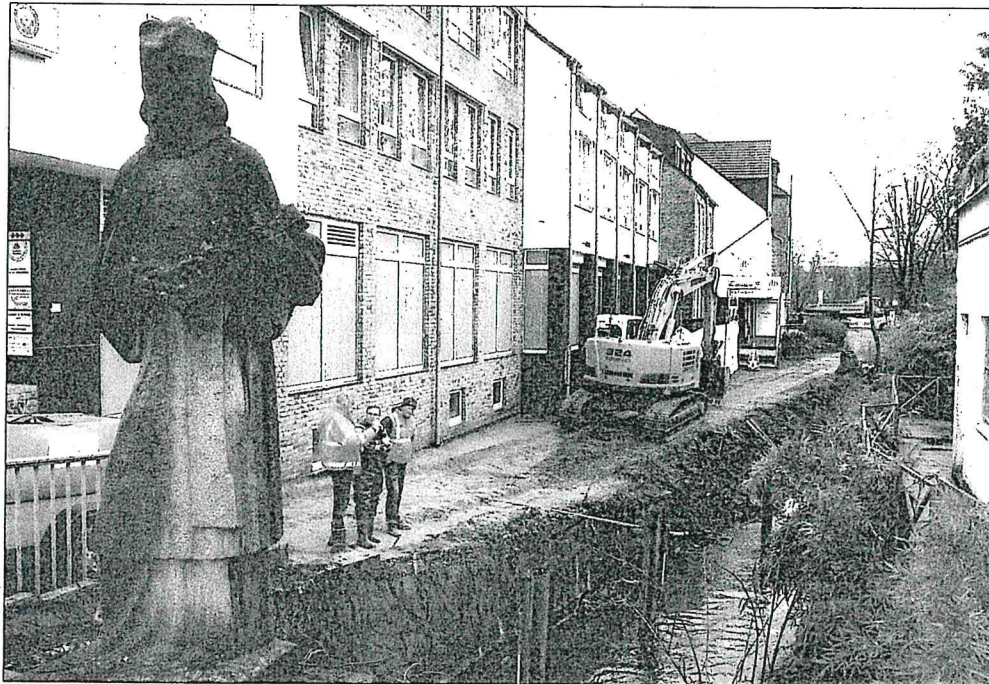
Die Kleine Erft in der Bergheimer Innenstadt erhält zwischen Hauptstraße und Marienstraße eine neue Stütz wand. (Foto: Vlaminc)
